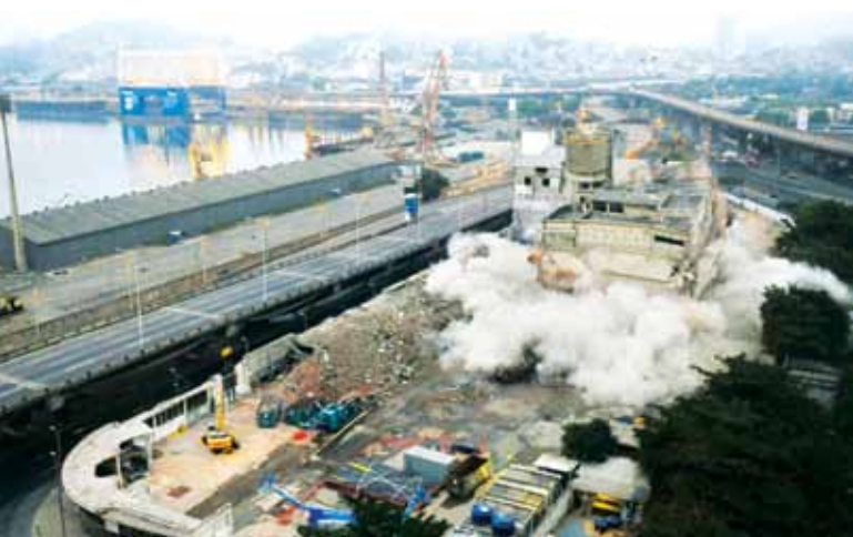
Implosão do moinho que dará lugar ao Port Corporate Tower
